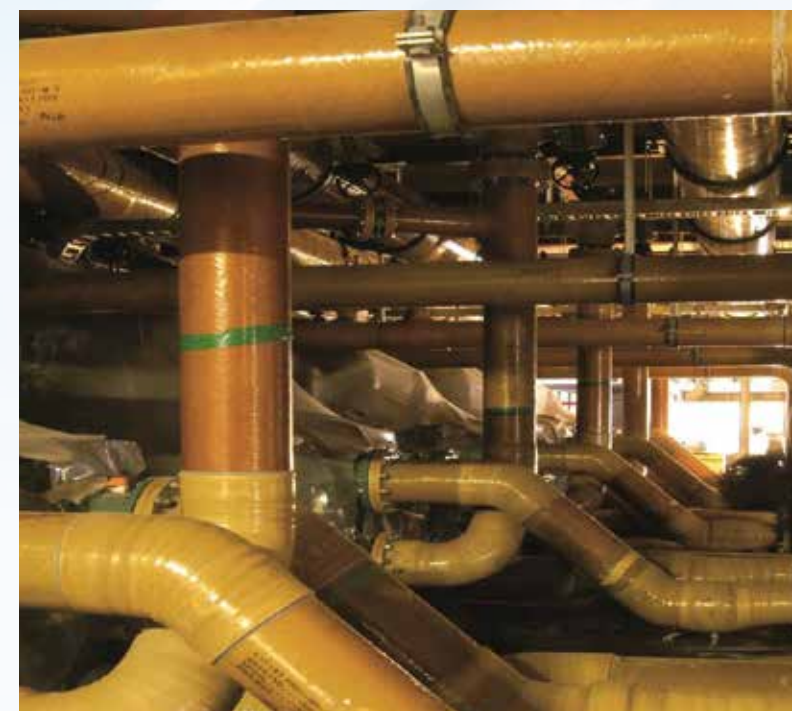
Junta con adhesivo
