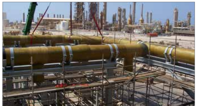
Fig. 7.8. Double pipe clamp
