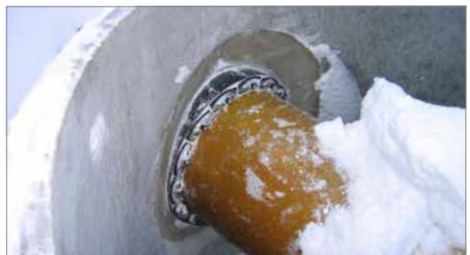
Fig. 7.13. Link seal
